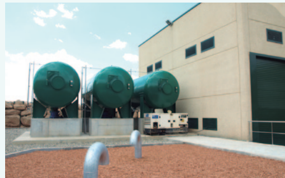
Edifici Tub Verd. Font: Aigües de Mataró
